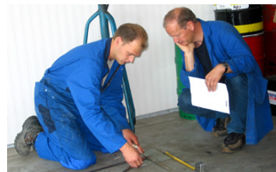
Abbildung 4.4 Abzeichnen der Löcher mit Hilfe der Bohrschablone
