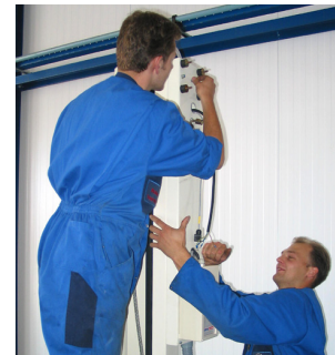
Figura 4.12 Casquillos distanciadores - Montaje del panel de mando
