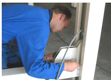
Figuur 4.18 Montage kabelschijven
