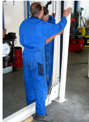
Figura 4.7 Colocación de los perfiles de bloqueo en las barras de acoplamiento
