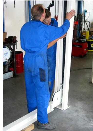
Abbildung 4.7 Einsatz der Verriegelungsprofile in die Querbalken
