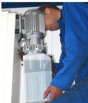
Figuur 4.13 Montage hydraulische unit
