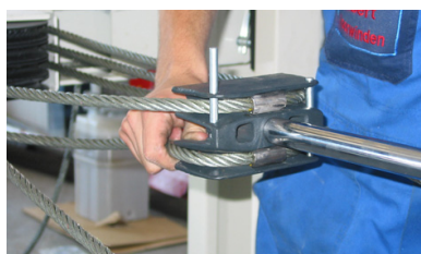
Figuur 4.24 Borgen van de kabels aan de plunjer
