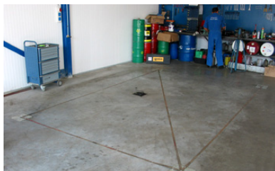
Rysunek 4.4 Zaznaczyć otwory przy pomocy wzornika
