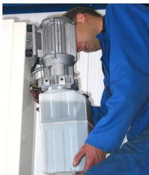
Rysunek 4.13 Montaż systemu hydraulicznego
