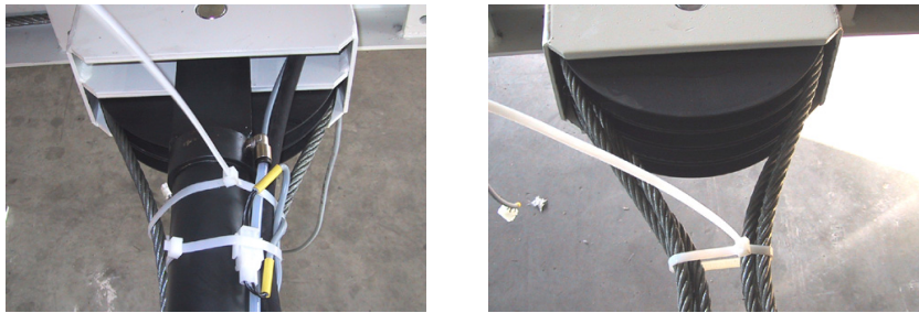
Figuur 4.26 Samenbinden van de kabels
