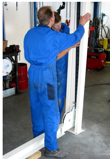
Figuur 4.7 Plaatsen van de grendelprofielen in de dwarsbalken
