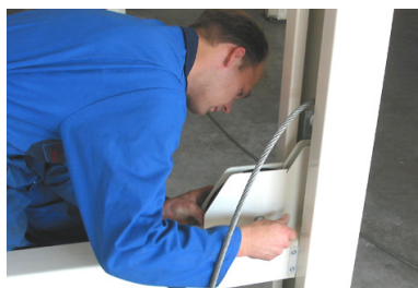
Rysunek 4.18 Montaż krążków kablonych.
