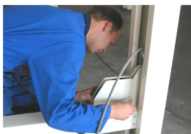
Abbildung 4.18 Montage der Seilscheiben
