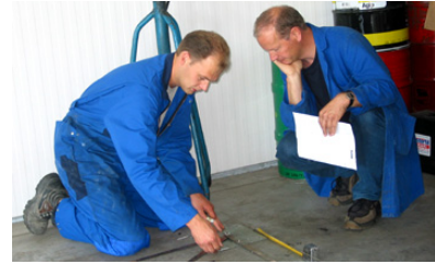
Illustration 4.4 Dessinez les trous au moyen du gabarit de perçage
