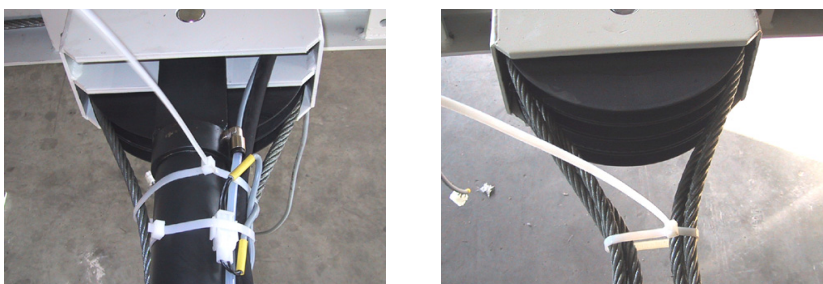
Figura 4.26 Atar los cables
