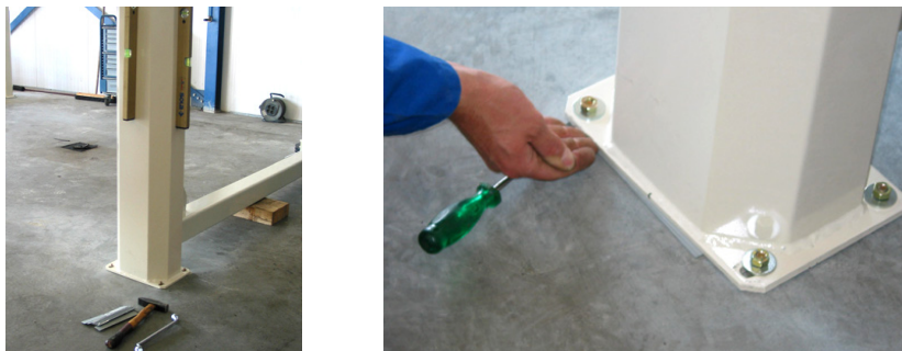
Figura 4.9 Colocar las columnas en posición vertical
