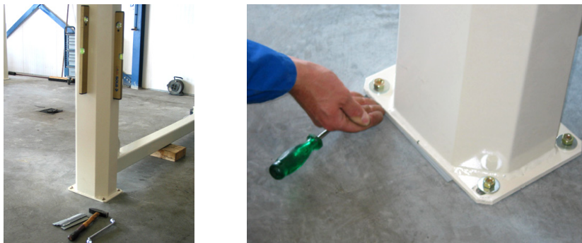
Illustration 4.9 Mise à la verticale des colonnes
