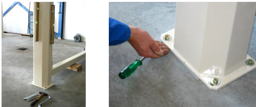
Rysunek 4.9 Pionowe ustawienie kolumn
