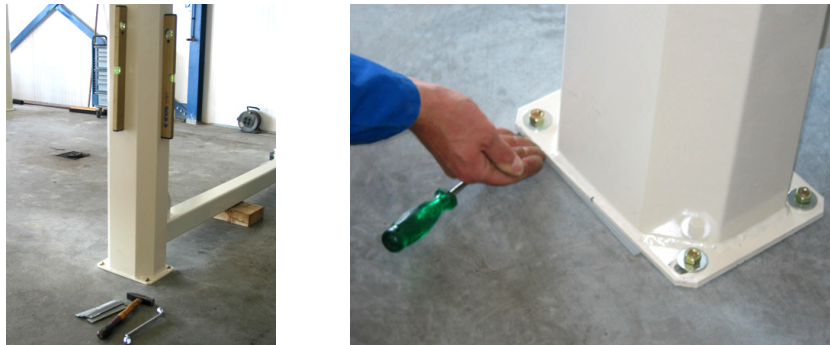
Abbildung 4.9 Vertikal setzen der Säulen
