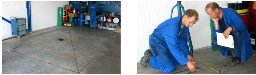
Figura 4.4 Marcar los orificios utilizando la plantilla de taladrado
