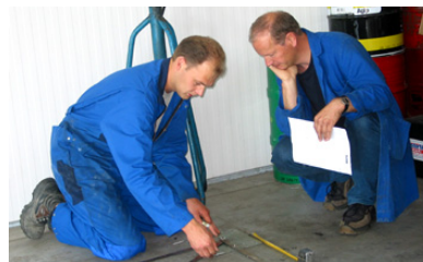
Rysunek 4.4 Zaznaczyć otwory przy pomocy wzornika
