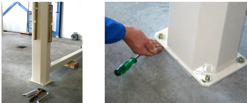
Figuur 4.9 Verticaal zetten van de kolommen
