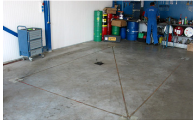
Illustration 4.4 Dessinez les trous au moyen du gabarit de perçage
