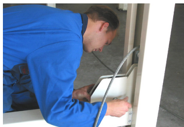
Figura 4.18 Montaje de las poleas de cable
