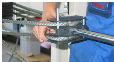
Abbildung 4.24 Sicherung der Kabel am Plunger
