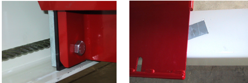
Illustration 4.29 Plaques de glissement et de support avec plaques de remplissage
