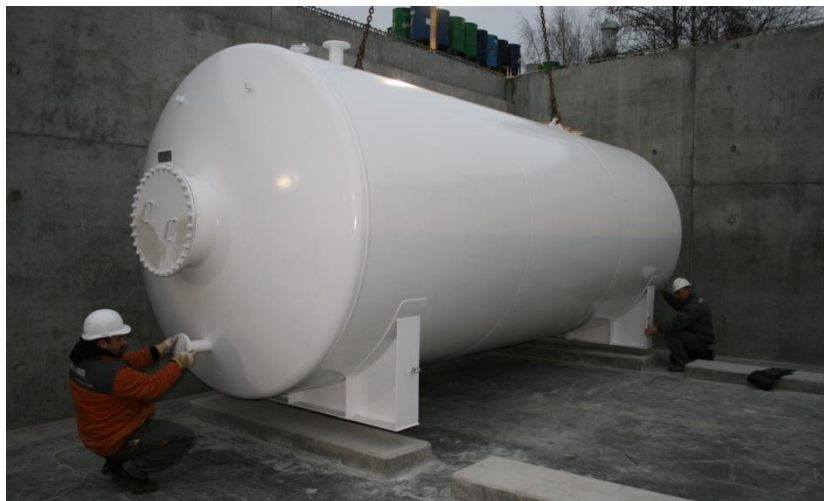
30 m 3 enkelmantlad cistern med diametern 2,5m
